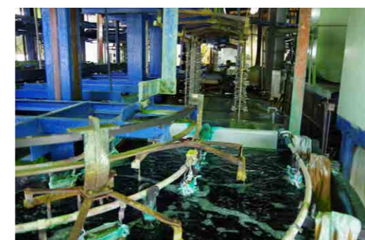
めっき処理槽
